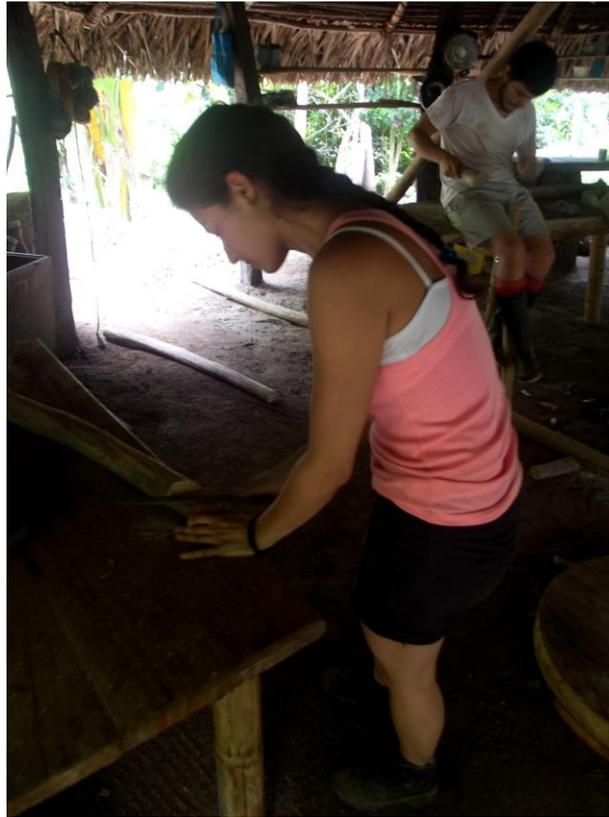
Unir los listones cortados, tallados y pulidos con pegamento (colbón madera) y reforzar la unión con tornillos para dar fuerza y estabilidad a la estructura triangular.
