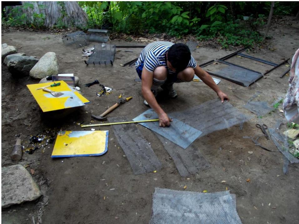
Disposición de los elementos que conformarán el horno para tener un mejor control y adecuación en el ensamblaje de la estructura.
