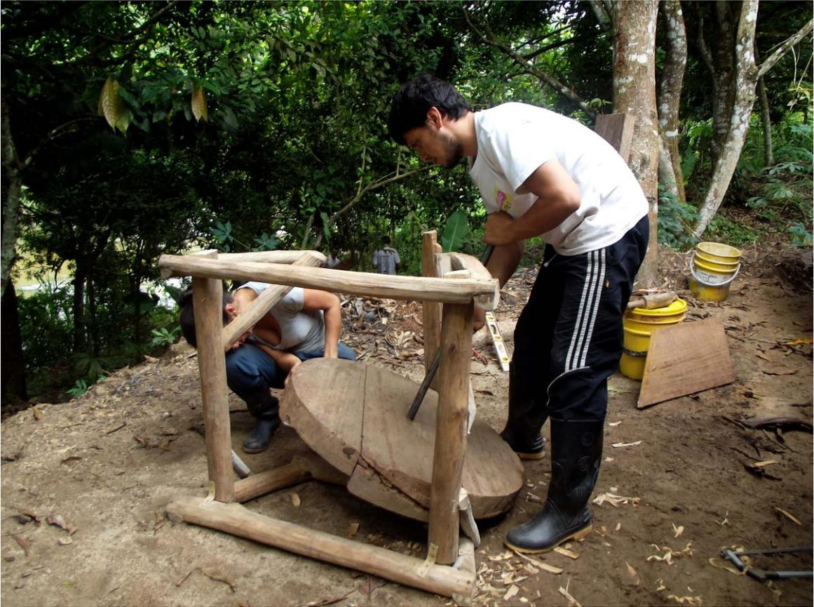
Prueba de ensamble ensamble entre la balinera (macho) y la excavación en el liston (hembra) y movimiento rotatorio, para serciorarnos de que el plato gire sin golpearse con la estructura.
