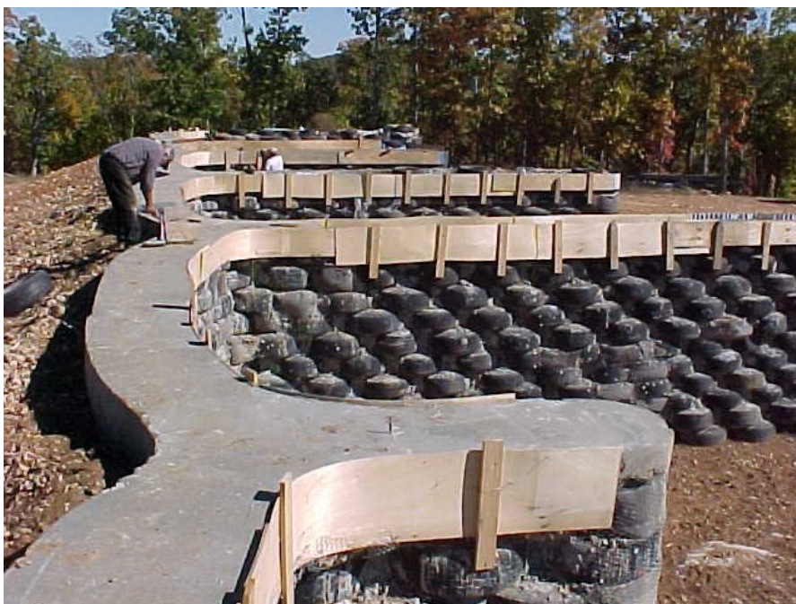
Foto de construccion de un Earthship
