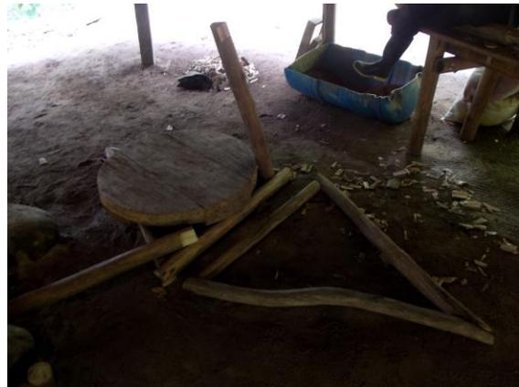
Realizando la primera prueba de ensamble para rectificar medidas de altura y que el torno quede lo más ergonómico posible
